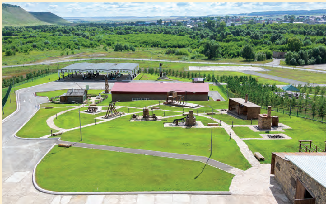
Музейный комплекс ШНБЗ. Вид сверху
