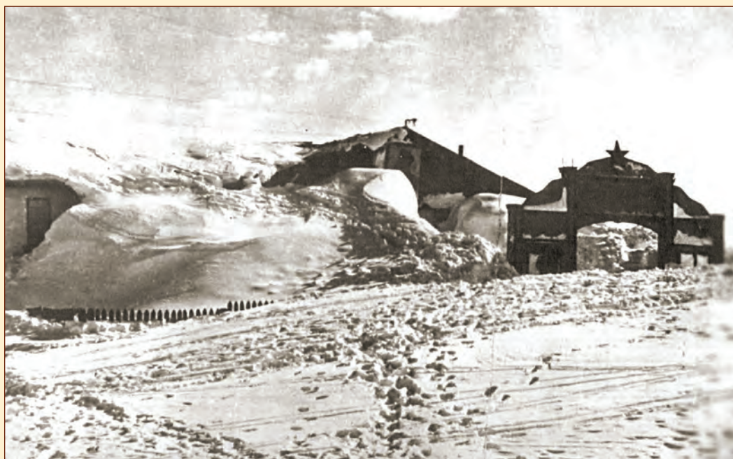
Первое здание Шугуровского нефтепромысла
